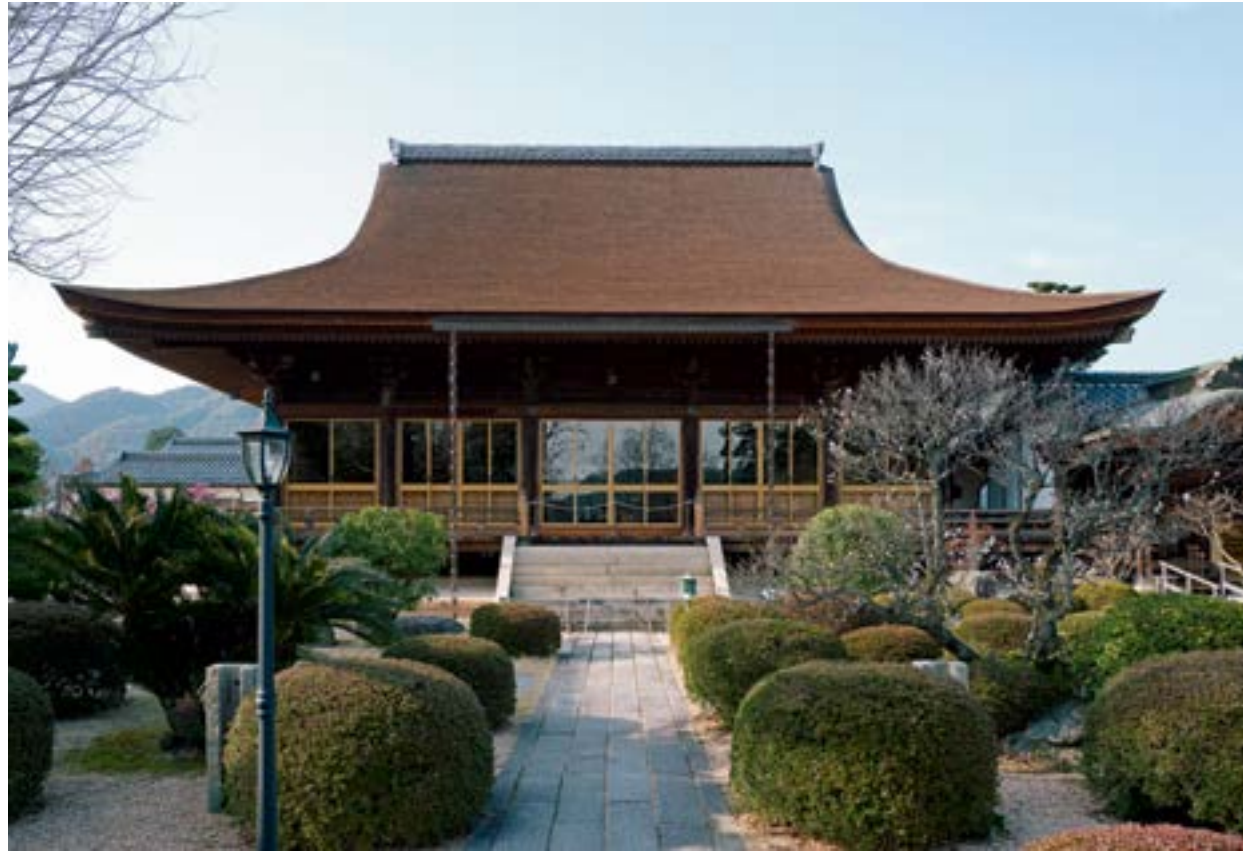
Ryufukuji-templet i Yamaguchi by. Det tog tre mand seks måneder at lægge det kurvede Hiwadabuki-tag. Foto: Corey Fuller
